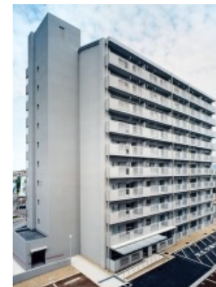
大阪府営守口庭窪金田 新築工事
