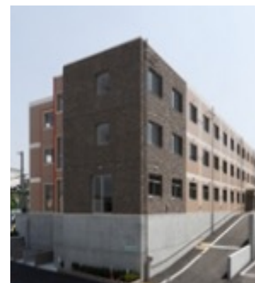
ロイヤルレジデンス御殿山弐号館 サービス付き高齢者住宅新築工事
