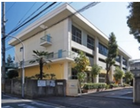
八雲東小学校 耐震補強工事
