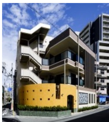
認定こども園メルクⅢ 新築工事
