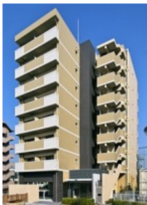
エルベコート豊中服部 新築工事
