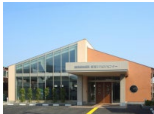
鶴見緑地病院橋波リハビリセンター 新築工事
