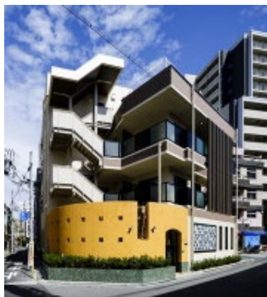
認定こども園メリックⅢ 新築工事
