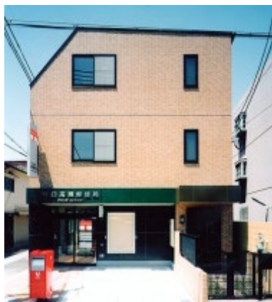
守口高瀬郵便局 新築工事
