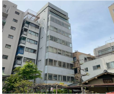
Hビル（大阪市北区）外壁改修工事
