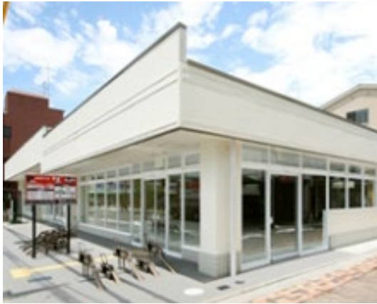
大和田駅前再開発 (薬局・コンビニエンスストア)
