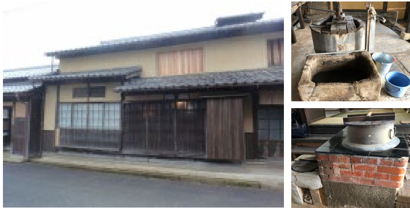
京都府与謝野郡与謝野町字加悦 改修工事 重要伝統的建造物群保存地区 明治初期～中期（築120～140年）
