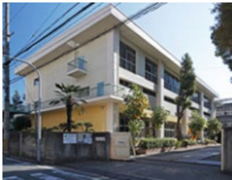
八雲東小学校 耐震補強工事
