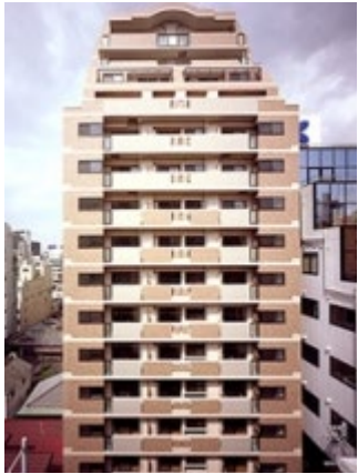
メロディーハイム大手前 新築工事
