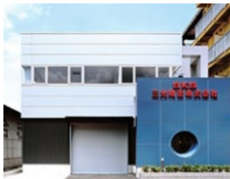
三光精密株式会社（東大阪市） 本社工場新築工事
