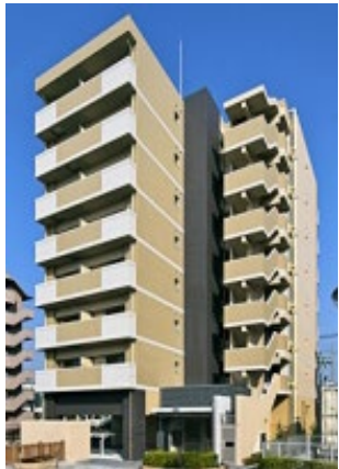
エルベコート豊中服部 新築工事
