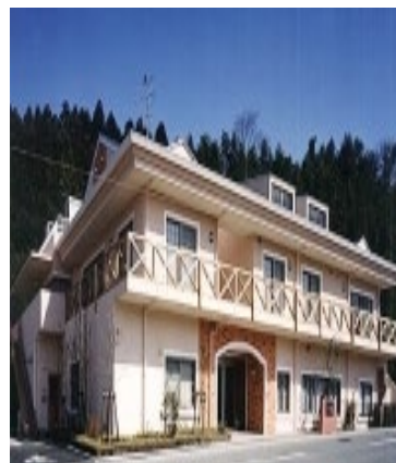
さくら苑老人デイサービスセンター 新築工事
