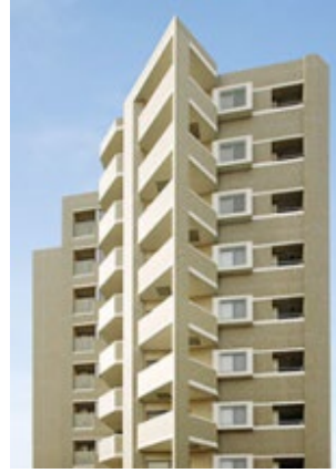
メロディースクエア古川橋駅前 新築工事
