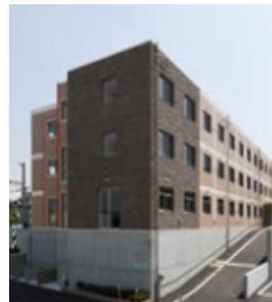
ロイヤルレジデンス御殿山式号館 サービス付き高齢者住宅新築工事
