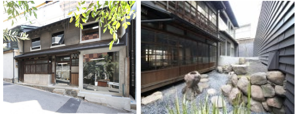
R-NAGAYA（大阪・谷町） 昭和4年の大阪長屋をリノベーション
