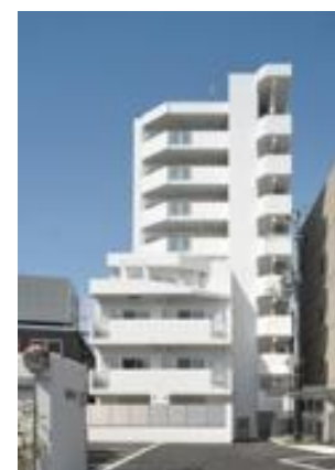
アーバネックス豊中 新築工事
