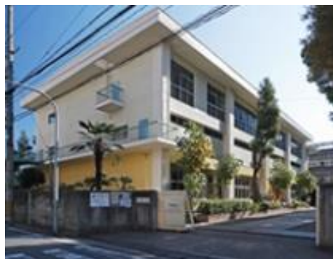
八雲東小学校 耐震補強工事
