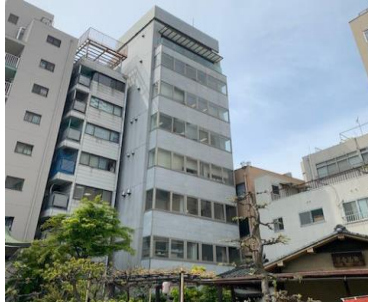
Hビル（大阪市北区）外壁改修工事
