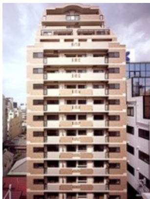
メロディーハイム大手前 新築工事
