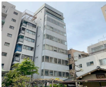
Hビル（大阪市北区）外壁改修工事
