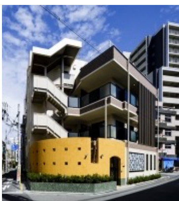
認定こども園メルクⅢ 新築工事
