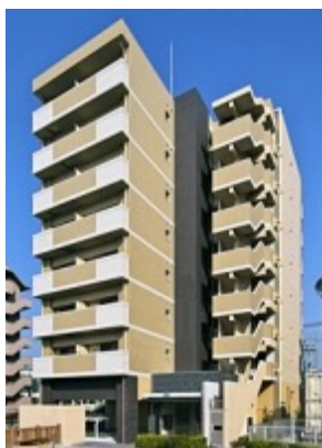
エルベコート豊中服部 新築工事
