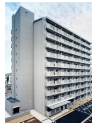
大阪府営守口庭窪金田 新築工事
