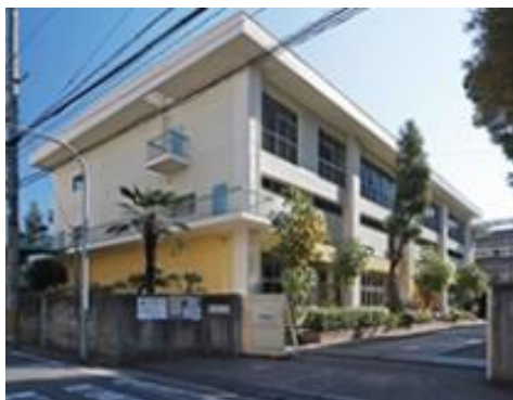
八雲東小学校 耐震補強工事
