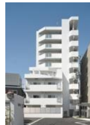
アーバネックス豊中 新築工事
