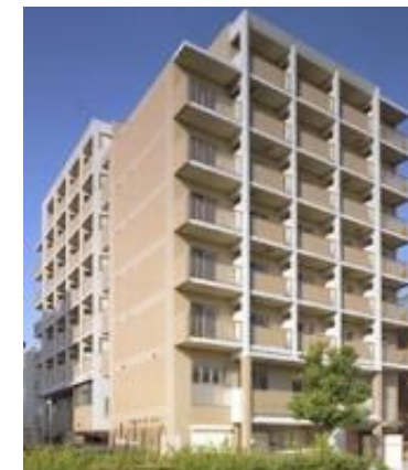
ナービス守口平代 かんでんジョイライフ サービス付高齢者住宅新築工事
