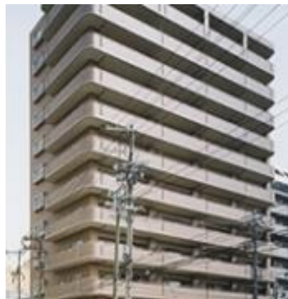
メロディーハイム守口駅前 新築工事
