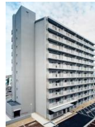
大阪府営守口庭窪金田 新築工事
