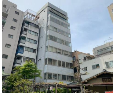
Hビル（大阪市北区）外壁改修工事
