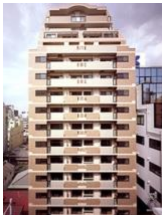
メロディーハイム大手前 新築工事
