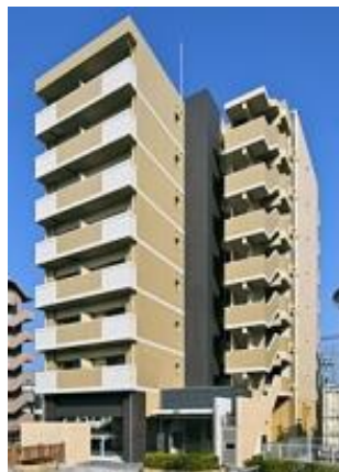
エルベコート豊中服部 新築工事
