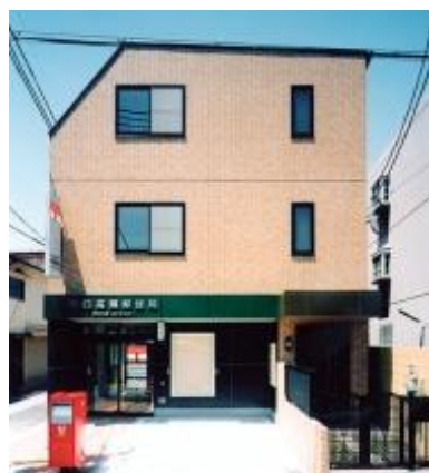
守口高瀬郵便局 新築工事
