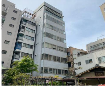
Hビル（大阪市北区）外壁改修工事
