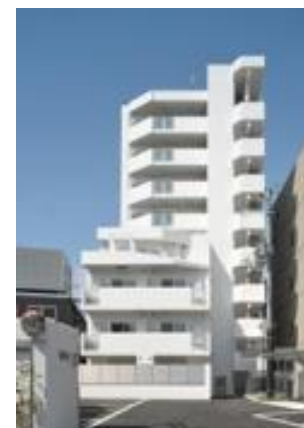
アーバネックス豊中 新築工事
