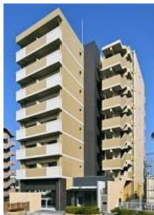
エルベコート豊中服部 新築工事
