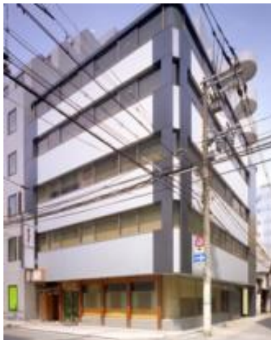
大規模改修工事
