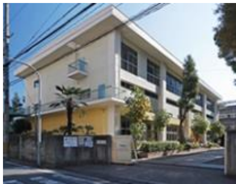
八雲東小学校 耐震補強工事
