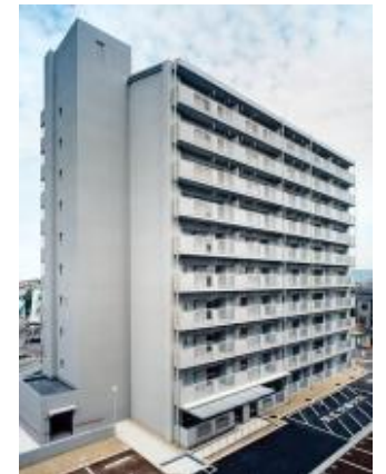
大阪府営守口庭窪金田 新築工事
