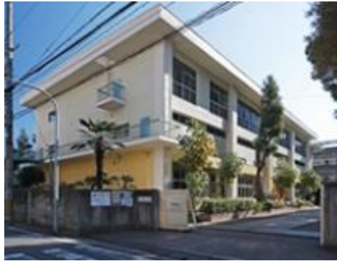
八雲東小学校 耐震補強工事
