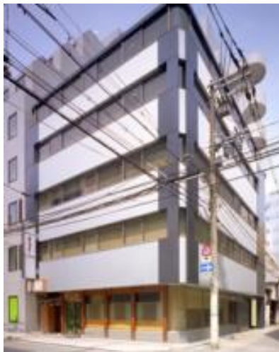
大規模改修工事
