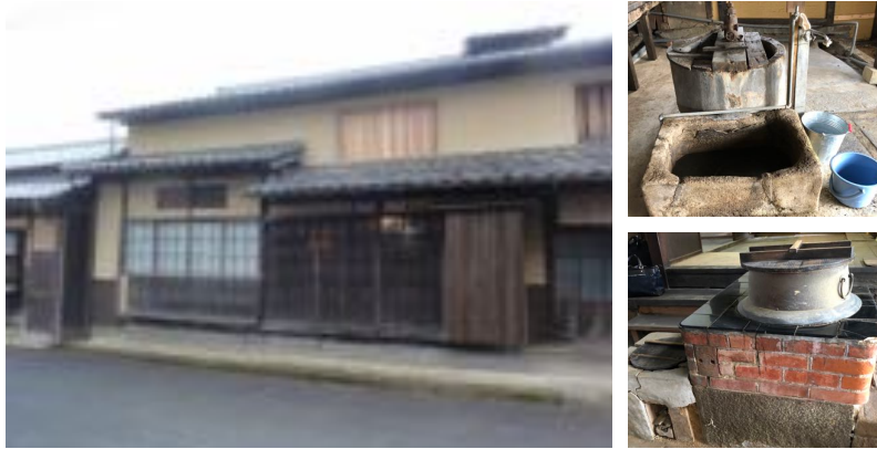
京都府与謝野郡与謝野町字加悦 重要伝統的建造物群保存地区 明治初期～中期（築120～140年）
