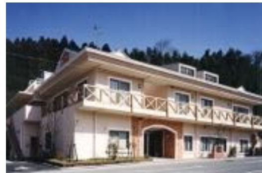
さくら苑老人デイサービスセンター 新築工事
