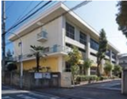
八雲東小学校 耐震補強工事
