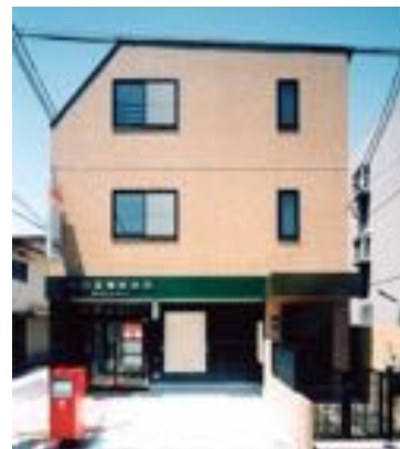
守口高瀬郵便局 新築工事
